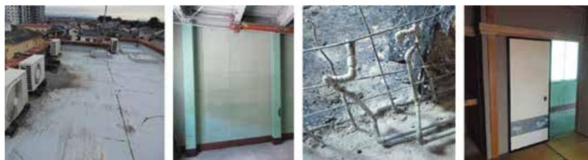
鉄骨3階建て、築40年以上、防水や水回りは完全に耐久年数を超えているため、まずは屋上の防水工事、外壁の耐水工事、そして水回りの撤去工事。
