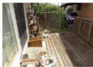
壁に開放的なウッドデッキ。
